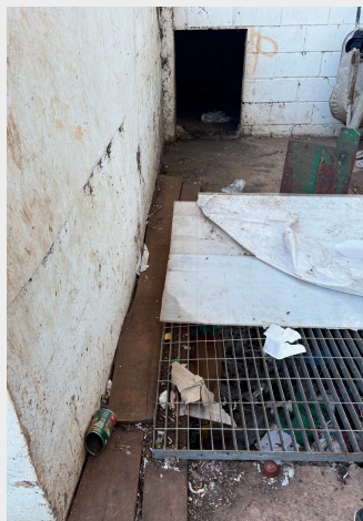
Caixa de manutenção da esteira com bueiros abertos no local e com lixo acumulado pela queda dos materiais
